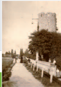
<< Historische Aufnahme der Ruine vom Maindam aus.
