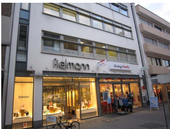
Renoviertes Objekt in der Bahnhofstraße.
