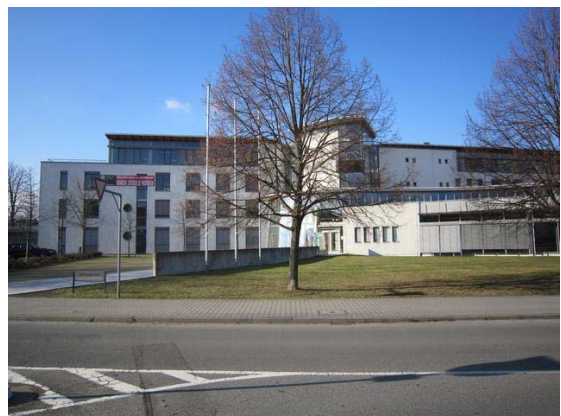
Öffentliche Gebäude mit Flächenreserve.
